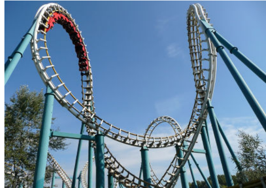
Gebogen profielen van een achtbaan
