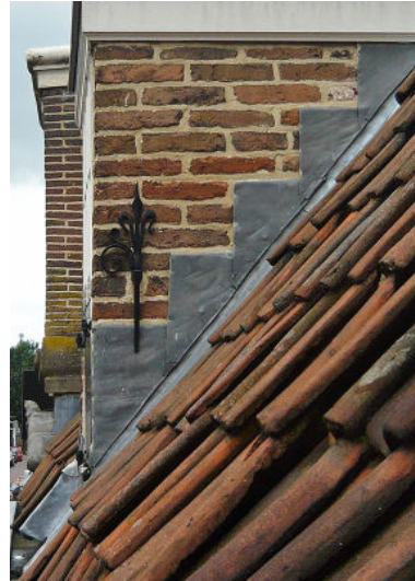
Loodloketten op een dakkapel
